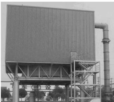
图 1 双良直接空冷单元样机
