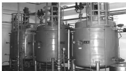
图 1 扩容蒸发器实物图
