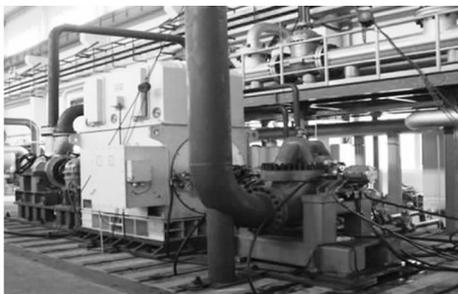
图 5 CAP1400 常规岛主给水泵联机试验
