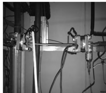
图 4 测试段安装实物图
