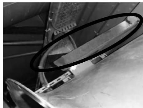
图 7 风机左边吊耳处现场加固图
