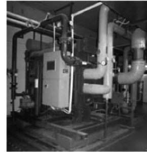
图 4 烟气补燃型溴化锂吸收式制冷机组
